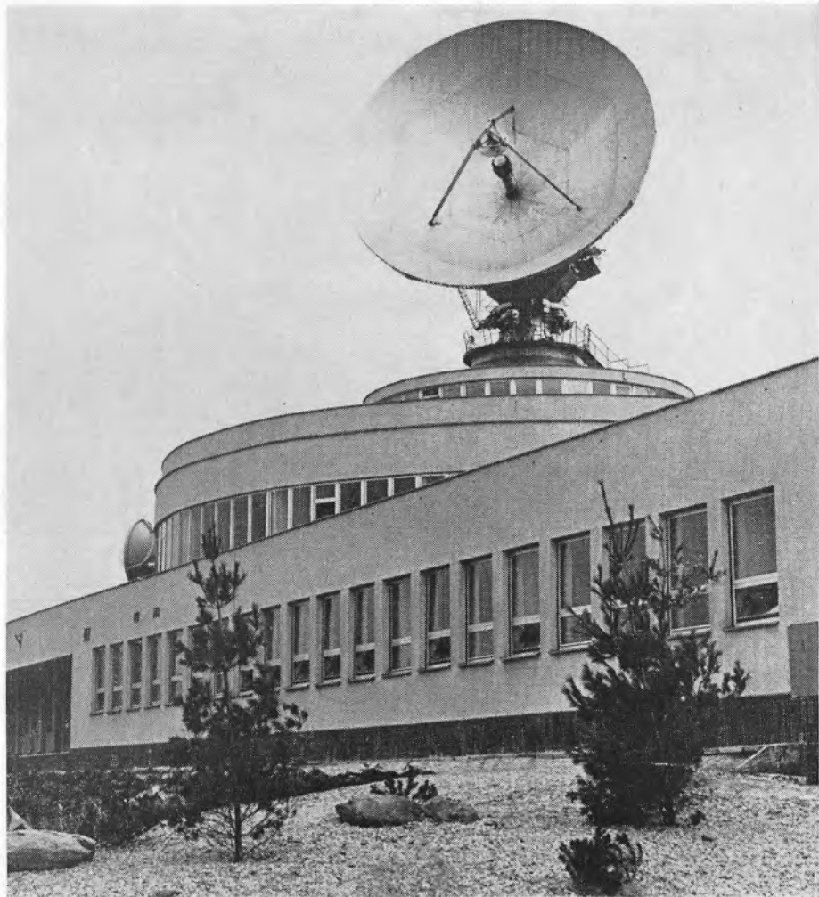
Spojové středisko pro komunikace přes družice
