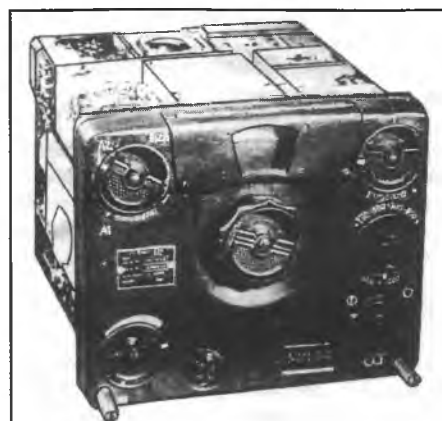
OBR. 11: Přijímač letu na cíl EZ6 - první provedení. Vlevo nahoře je přepínač druhu provozu a nastavení šíře pásma, stupnice a „vyjasňovač“ /C155/. Uprostřed tandemový knoflík hrubého a jemného ladění stupnice, vedle je spínač rozsahů. V dolní části je nastavení hlasitosti, kulatá zásuvka sluchátek a přepínač pro všesměrový, cílový a zaměřovací provoz. Obdélníková zásuvka je pro připojení kontrolního měřícího přístroje.
